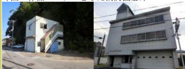
こちらは丹波市柏原町の消防団倉庫
