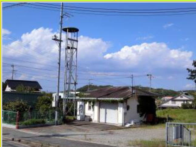
神戸市北区淡河町淡河本町の消防団倉庫
